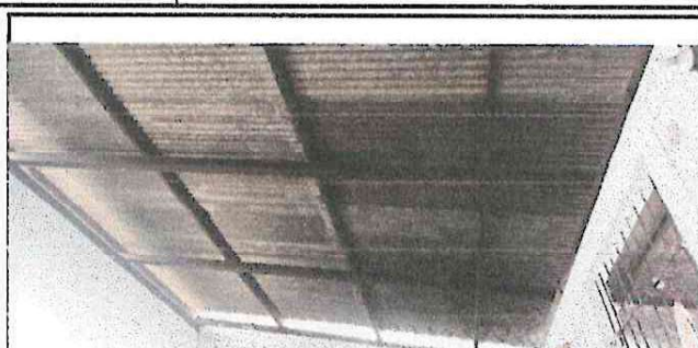
Foto 2: Cambio de lamina por deterioro y oxido en aulas.
