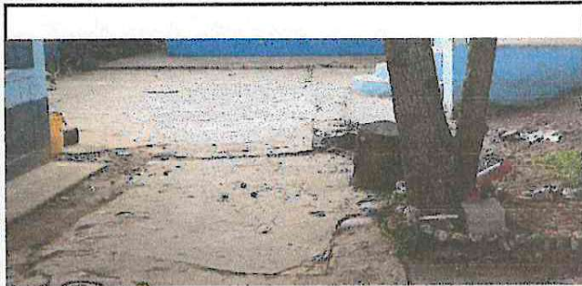
Foto 8: Sustitución de Losa de patio por mal estado.
